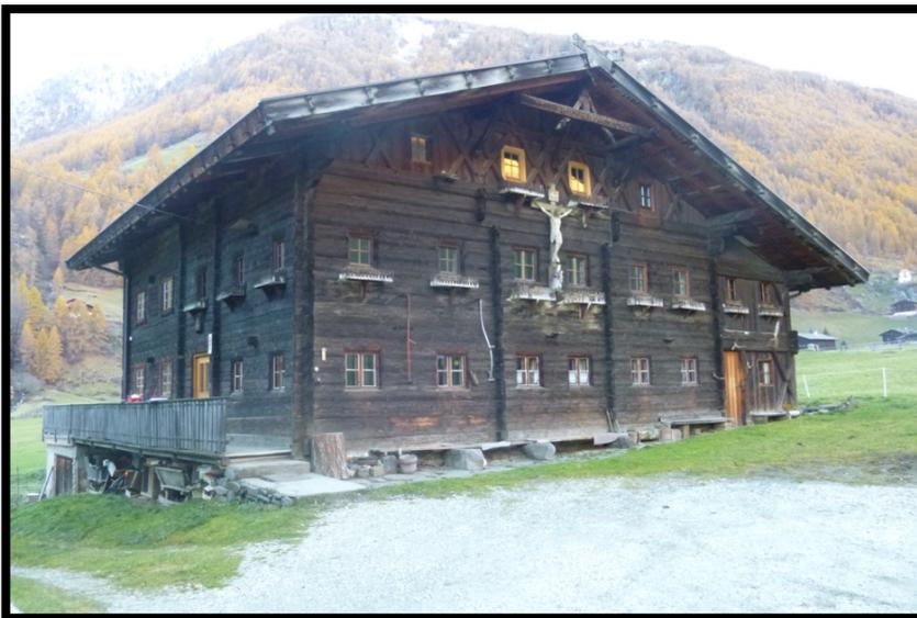
*Bild 22: Schnalstal- Holzblock Bauweise mit kleinen Fensteröffnungen*
