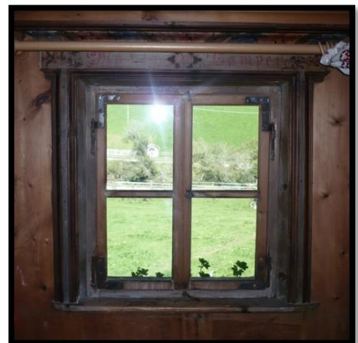
*Bild 21: Sanierung der Innenverglasung durch K- Glas*
