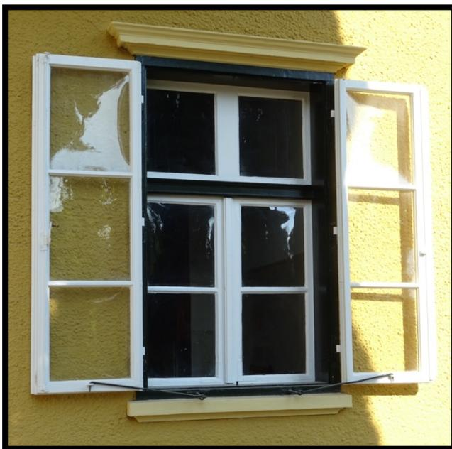
*Bild 8: Grazer Kastenfenster mit Zylinderglas
